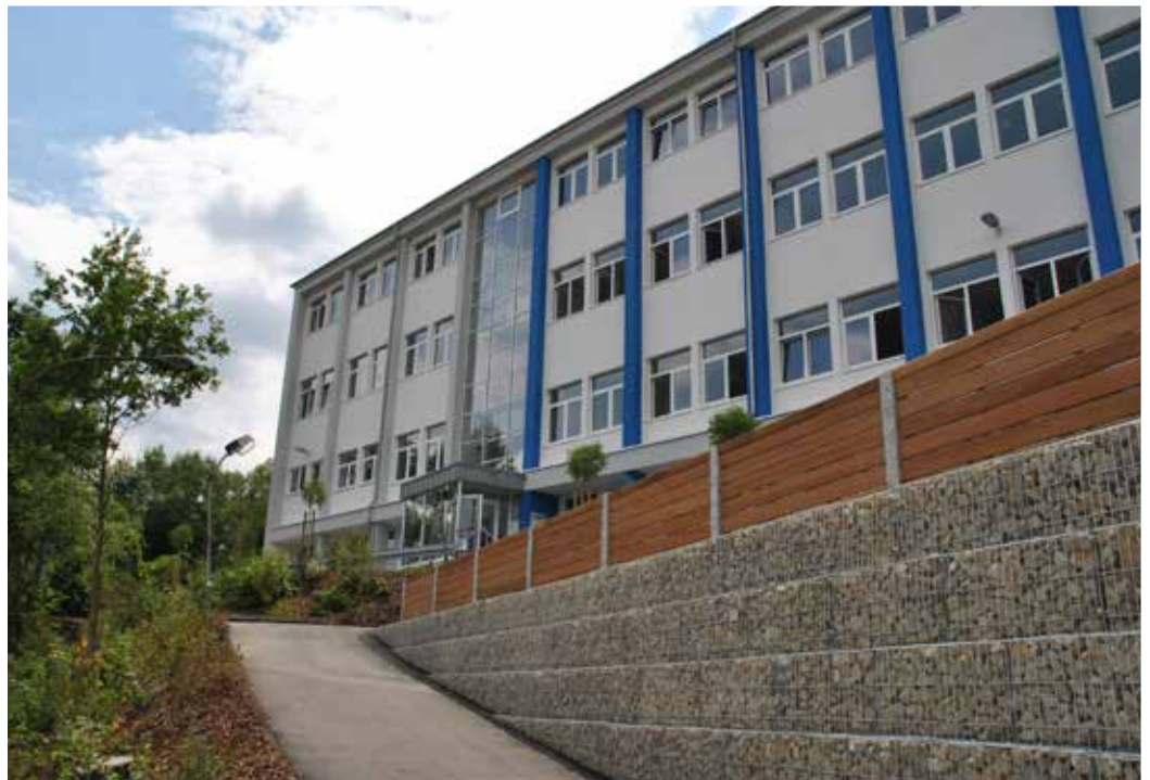
Das Gebäude der ASW in Neunkirchen/Saar
